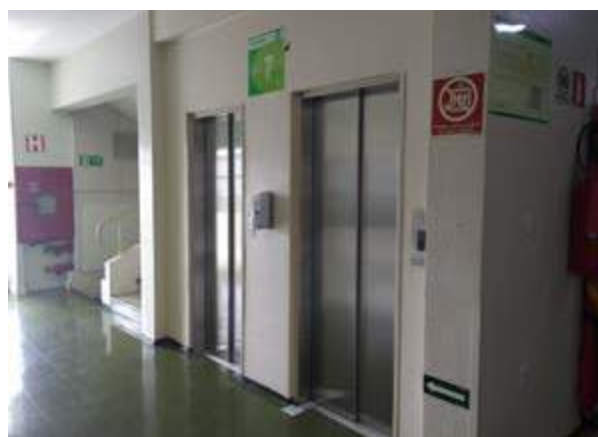
Modernização de dois elevadores de serviços
