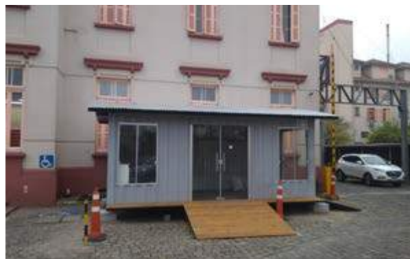
Instalação de contêiner na guarita
